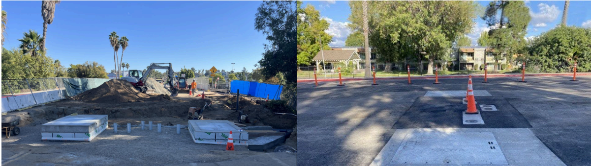
Izquierda: Dos bóvedas de acceso recién instaladas a lo largo de la calle Harding. Derecha: Camino recién pavimentado tras las mejoras a la estructura, con planchas de seguridad para el tránsito.
